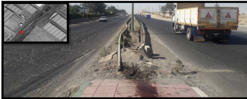
شکل ۵: وضعیت نامناسب اتصال جدول میانی با گاردریل جداکننده
