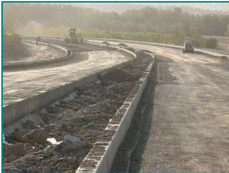
اجرای لایه ساب بیس
