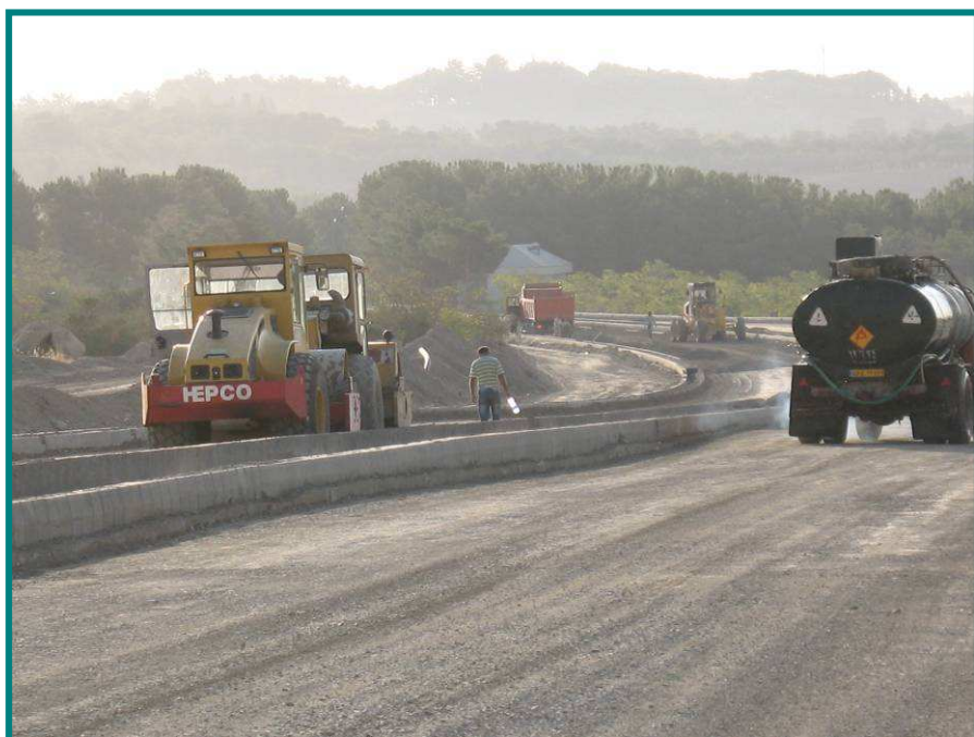
اجرای لایه ساب بیس
