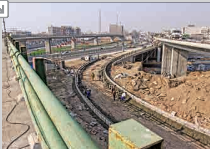
پل عوارض در تقاطع بزرگراه امام علی (ع) به مرحله تکمیل نزدیک شده است
