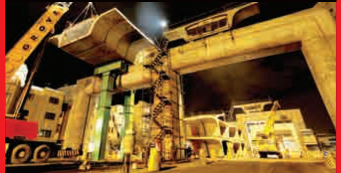
احداث ۶ کیلومتر پل رمپی تکیه داده بر تیرهای عریض دروازه‌ای؛ این عملیات غالباً در شب هنگام صورت می‌گرفت تا ضمن تامین ایمنی بیشتر پروژه، تا حد امکان از انسداد ترافیکی مسیر صدر موجود خودداری شود.
