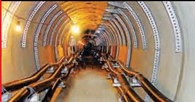
احداث تونل ۶۲۱۰ متری انتقال برق در مدت زمان ۶ ماه (۹۰/۸/۸ تا ۹۰/۲/۸) محقق شد. به واسطه بهره‌مندی از این تونل بود که امکان جمع آوری دکل‌های برق فشار قوی از میان بزرگراه صدر فراهم شد و البته یک تونل مشترک تاسیسات شهری به تهران هدیه شد.
