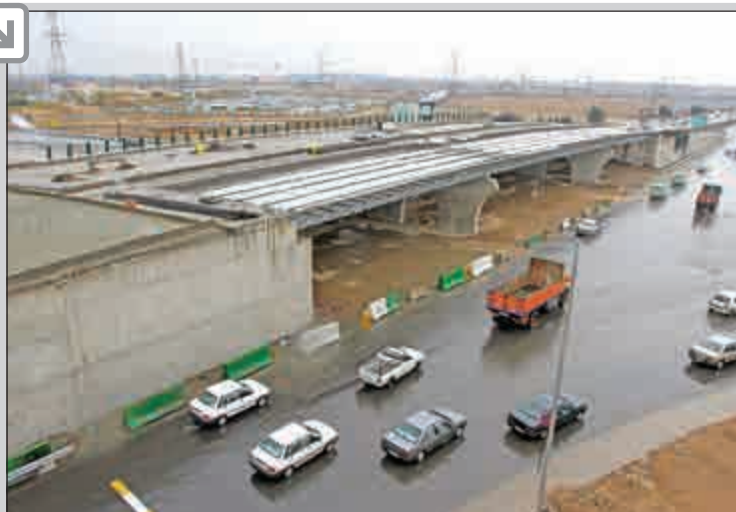
پل تقاطع ورودی بهشت‌نهر (امیر) با بزرگراه صالح آباد در مراحل پایانی
