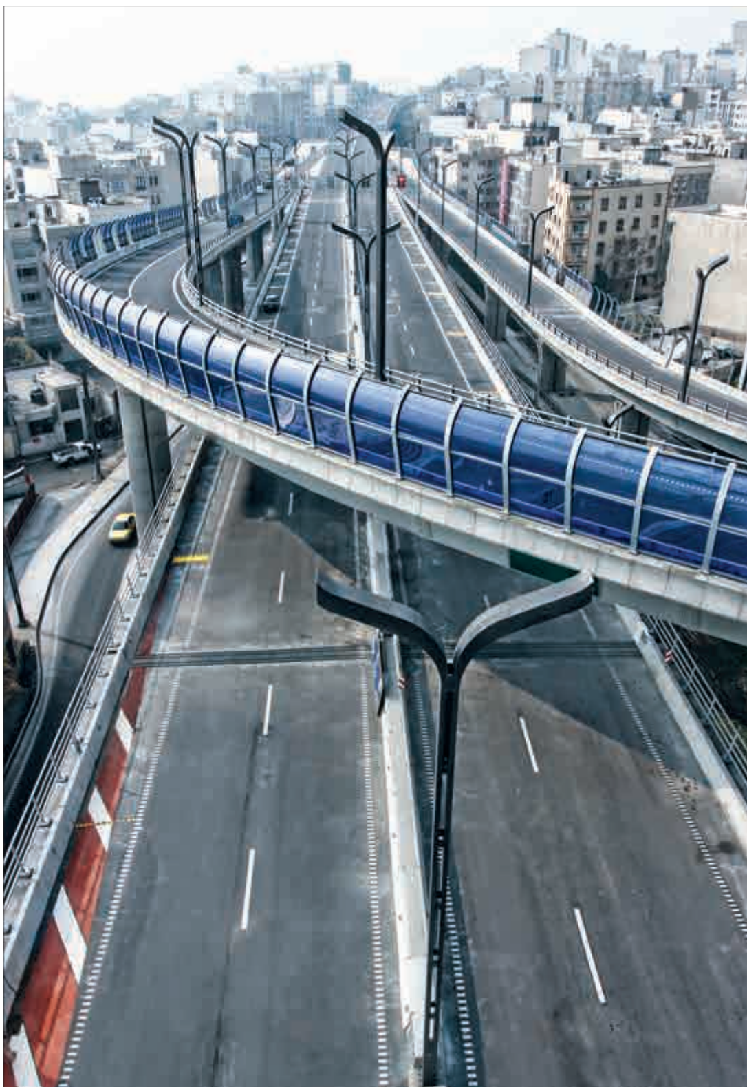
نمای نهایی از بزرگراه طبقاتی صدر - تقاطع چهار سطحی قیصریه
