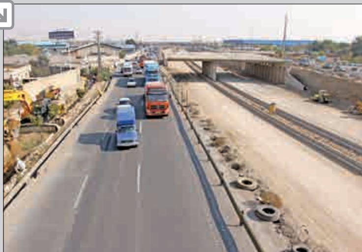
پروژه احداث تقاطع غیر همسطح چهارراه ایران خودرود، بزرگراه فتح
