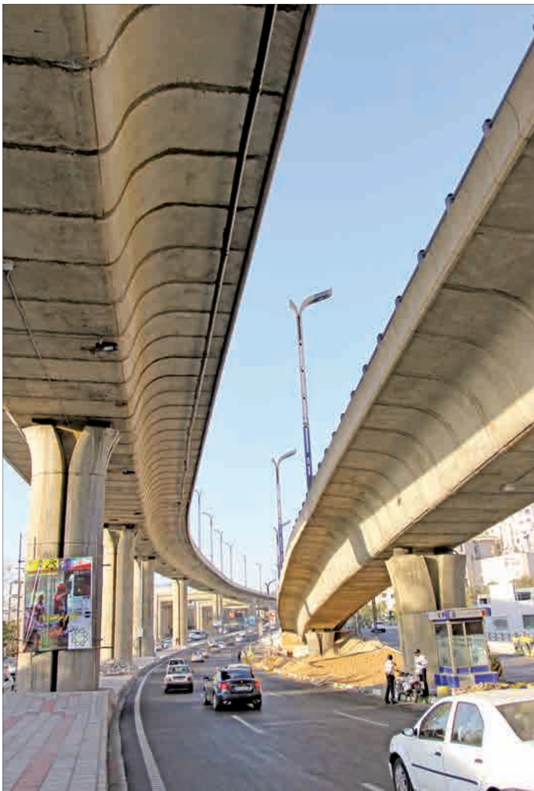
نمایی از آخرین وضعیت پروژه بزرگراه طبقاتی صدر
