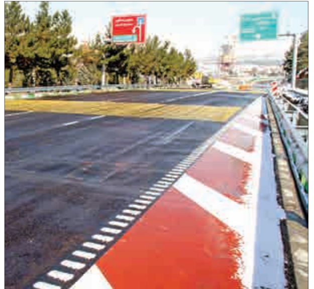
با احداث مسیرهای دسترسی به باند شمال بزرگراه شهید بابایی و ایجاد تقاطع‌های غیرهمسطح در طول مسیر
