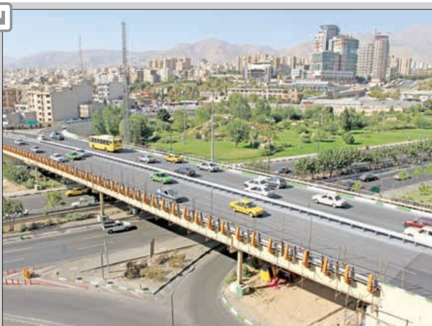
عملیات مقام سازی و پیساری لرزای پل ازمایش که توسط شرکت پادمان سازه در حال اتمام است
