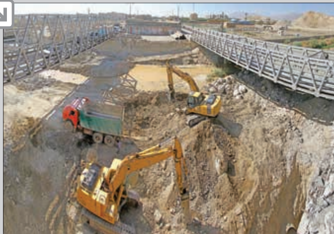
مراحل آماده سازی نصب پل فلزی در محل تقاطع روخانه کین با بزرگراه فتح
