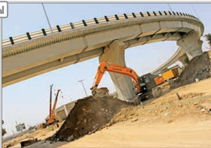
پل‌های تقاطع غیرمستقیم بزرگراه صالح آباد با بزرگراه بهشت‌زهر (س)
