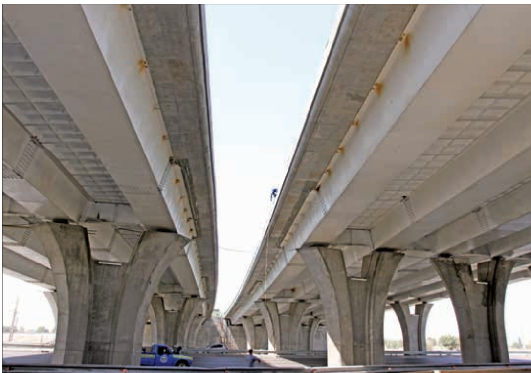
تقاطع غیر همسطح بزرگراه سعیدآباد بزرگراه آزادگان
