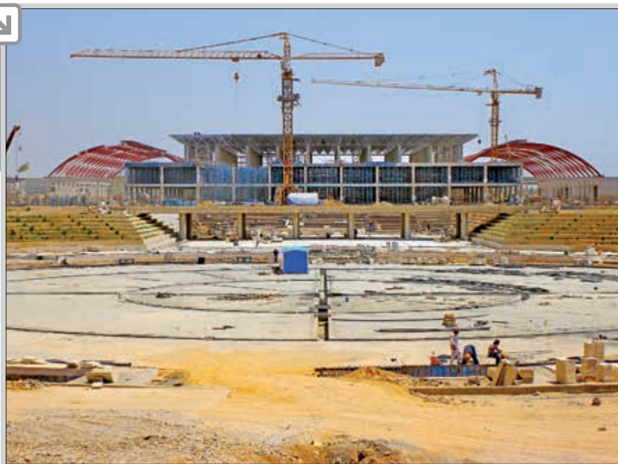
سازمان راه و ترابری در حال تکمیل ساخت چهار طبقه ۲۹ خردادماه ۱۳۹۲
