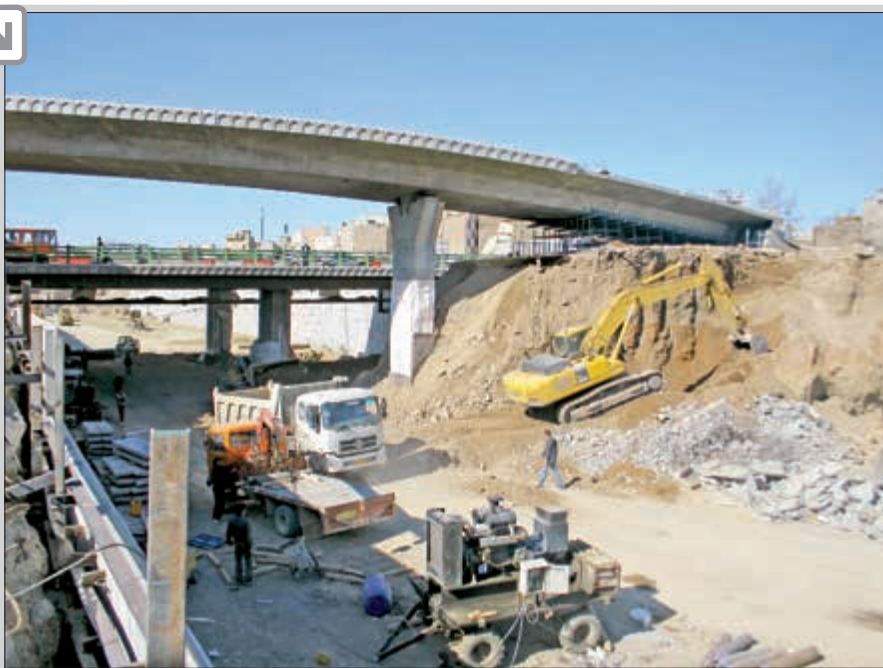
احداث مسیر بزرگراه علم علی (ع) زیر پل تقاطع خیابان سیلان - چهارشنبه ۱۶ اسفند ۱۳۹۱
