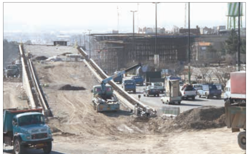
چندما از پروژه های عمرانی که در حومه شهر اجرا می شود
