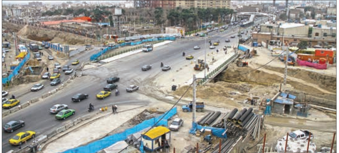
نمایی از عملیات اجرایی در تقاطع خیابان دماوند با بزرگراه امام علی (ع)
