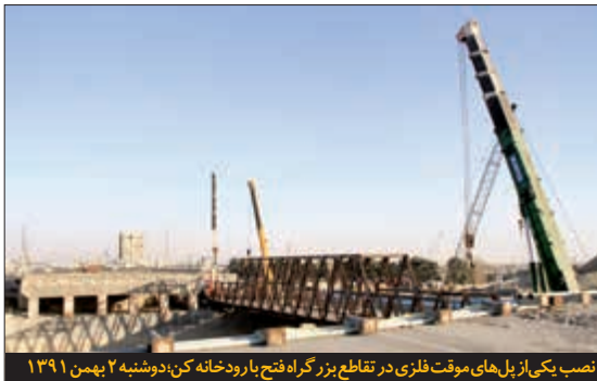
نصب یکی از بل‌های موقت فلزی در تقاطع بزرگراه فتح بارودخانه کن، دوشنبه ۲ بهمن ۱۳۹۱
