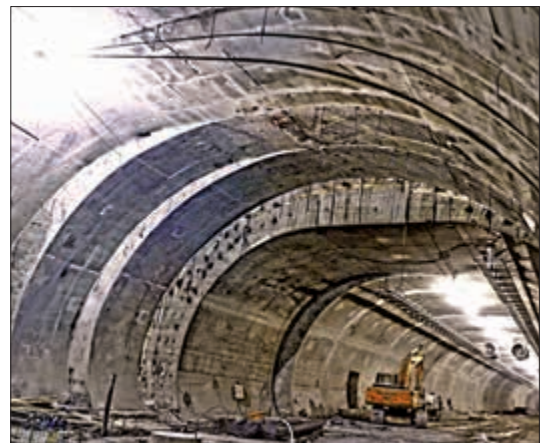
نمای از آخرین وضعیت پروژه تونل شمالی
