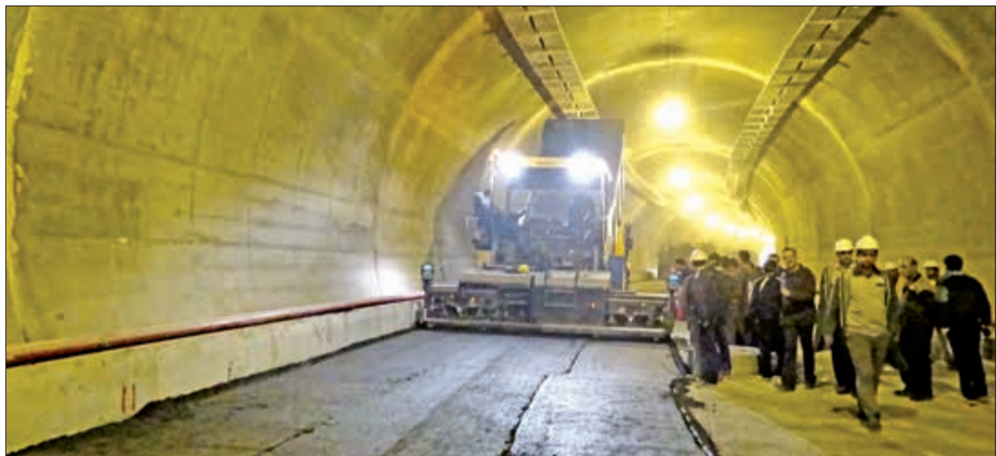
نمایی از عملیات آسفالت ریزی در پروژه احداث تونل پیش
