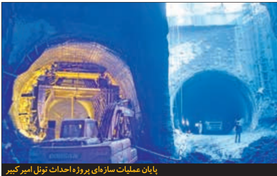
پایان عملیات سازه‌های پروژه احداث تونل امیر کبیر
