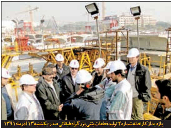
بازدید از کارخانه شماره ۲ تولید قطعات بتنی بزرگراه طبقاتی صدر، یکشنبه ۱۳ آذرماه ۱۳۹۱
