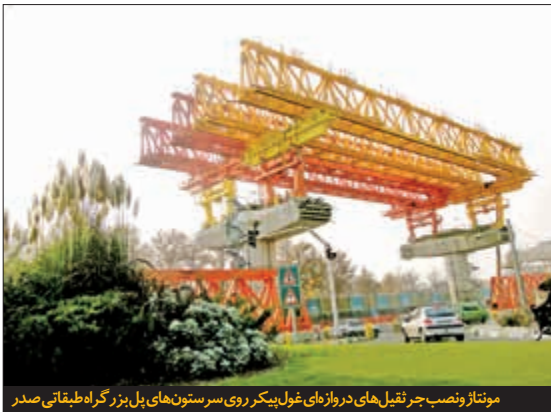
مونتاز و نصب جرثقیل‌های دروازه‌ای غول‌پیکر روی سرستون‌های پل بزرگراه طبقاتی صدر
