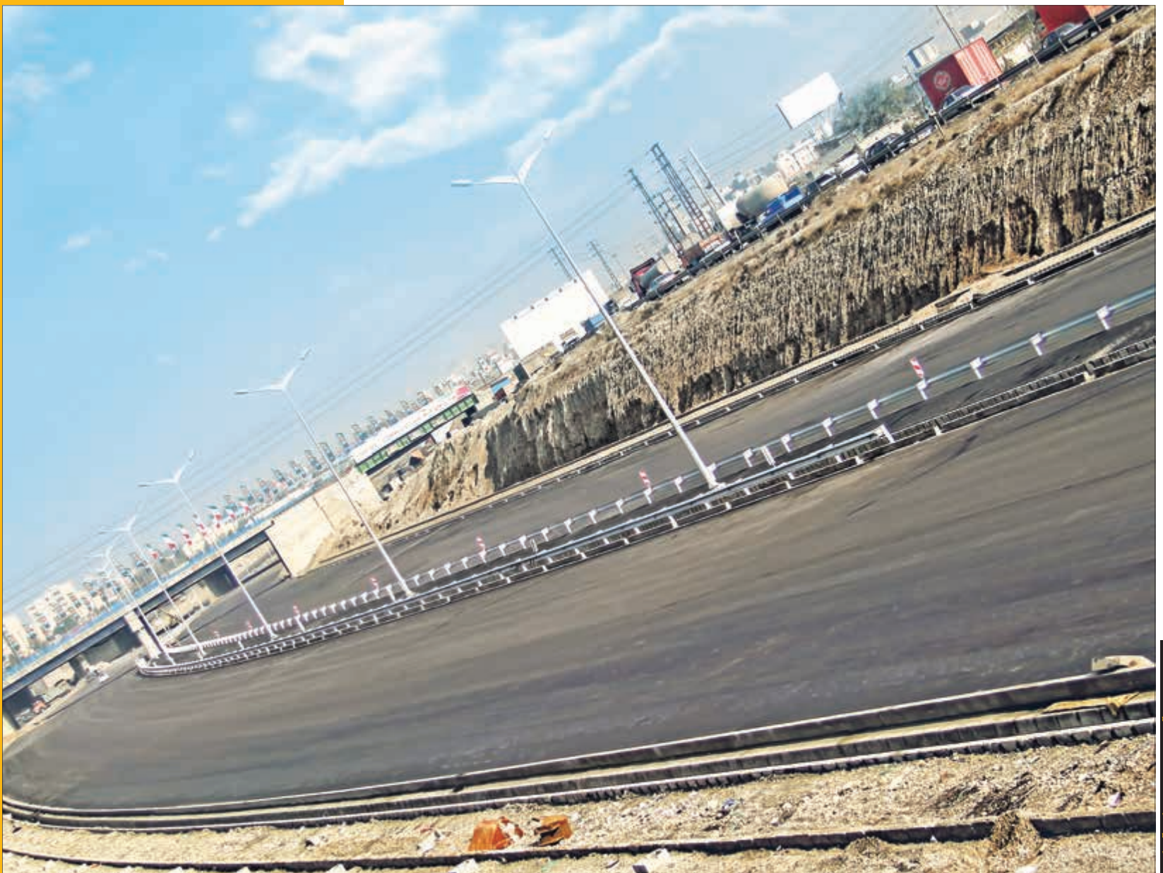
نمایی از بخشی آماده بهره‌برداری در بزرگراه آزادگان
