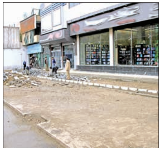
بخش های از خیابان پیروزی که عملیات تملک معارضات ملکی و تعریض معبر در آن ها انجام شده است
