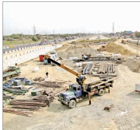
دو نما از عملیات اجرایی پروژه بزرگراه آزادگان
