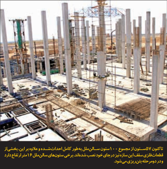
سالن‌های سه‌قلوی نمایشگاهی، تحت یک فرآیند نسبتاً پیچیده فنی برای نصب سازه فولادی سقف آماده‌شدند. جاگذاری و نصب میله‌های مهاری که از اقدامات پیش‌نیاز نصب سازه سقف محسوب‌می‌شود، با نظارت‌های دقیق کیفی اجرا شده‌است.
