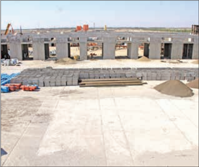
سالن‌های سه‌قلوی نمایشگاهی، تحت یک فرآیند نسبتاً پیچیده فنی برای نصب سازه فولادی سقف آماده‌شدند. جاگذاری و نصب میله‌های مهاری که از اقدامات پیش‌نیاز نصب سازه سقف محسوب‌می‌شود، با نظارت‌های دقیق کیفی اجرا شده‌است.
