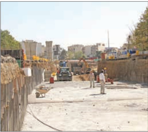
چند نما از عملیات اجرایی ساخت زیر گذر قطار به
