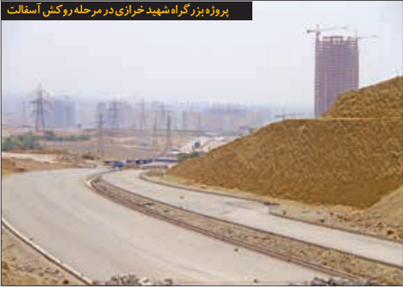
پروژه بزر گراه شهید خرازی در مرحله روکش آسفالت
