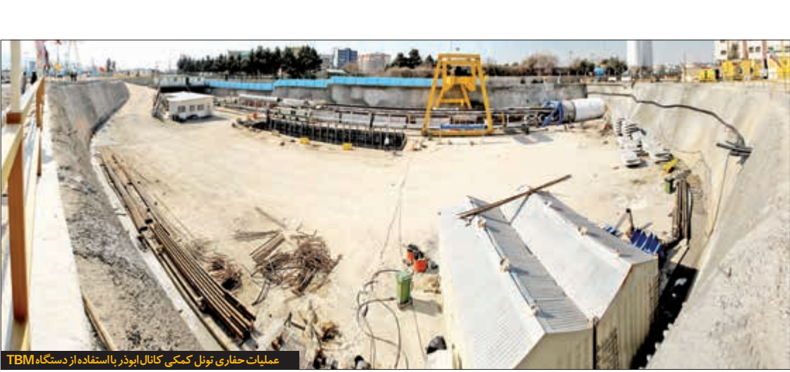
عملیات حفاری تونل کمکی کانال ابودر با استفاده از دستگاه TBM
