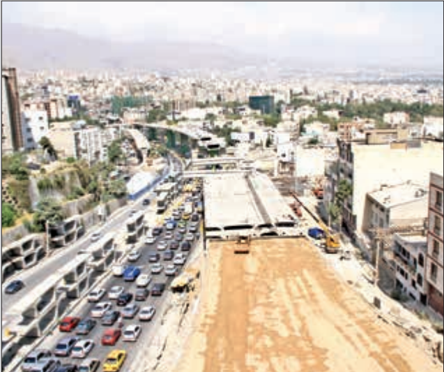
عملیات خاک‌ریزی کوله‌رمپ‌غربی در حدود ۹۰ درصد پیشرفت‌فیزیکی داشته‌است. عملیات مذکور توسط دست‌اندر کاران پروژه به‌سرعت دنبال می‌شود تا فضای مسطح این بخش از پروژه به‌عنوان محلی برای مونتاژ و آماده‌سازی گنتری کرین‌ها استفاده شود.
