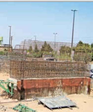
عملیات اجرایی در دوربرگردان جنوب به جنوب جاده قدیم قم و علاوه بر احداث کامل کوله‌ها، تمام ستون‌های دو طرف تقاطع
