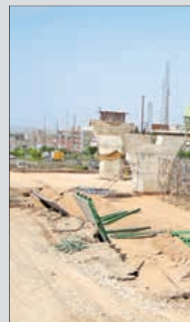
از سایر بخش های پروژه جلوتر است. قطع احداث شده است.
