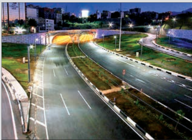
احداث تونل رسالت از آنجا که اولین تجربه شهرداری تهران در امر تونل سازی شهری بود، سال‌ها به طول انجامید و این پروژه در نهایت تیرماه سال ۸۵ به بهره‌برداری رسید.
