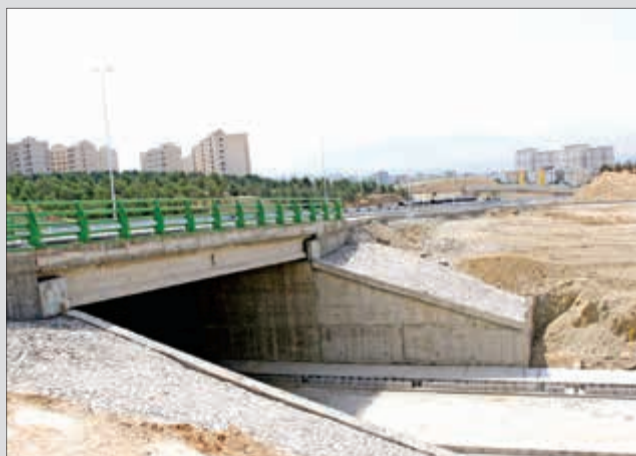
طول زیرگذر شهر کامید ۵۵ متر و عرض آن ۱۰ متر است که به روش اجرای فونداسیون، دیوار و دال بتنی احداث شده است. متوسط ارتفاع دیوارها از زیر فونداسیون تا روی دال بتنی به ۹ متر می رسد.
