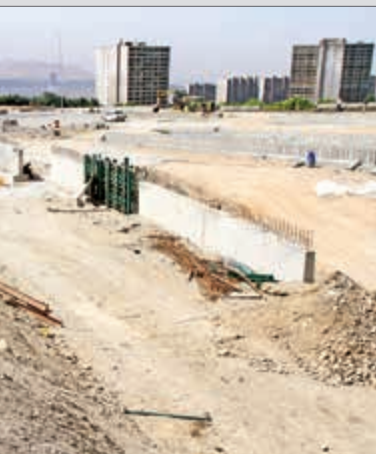
مسیر در دست اجرا با ۲۲۵۰ متر طول و ۴۵ متر عرض در یک پوسته ۷۶ متری احداث می‌شود.
