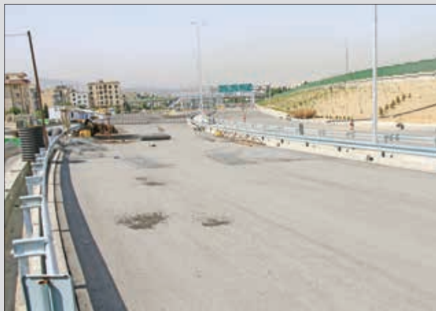
مسیر حذف فاصل پل استقلال تا زیرگذر شهر کامید هم‌زمان با بهره‌برداری از پل استقلال زیر آسفالت رفته است. بخش باقی مانده مسیر شامل یک مسیر حدود ۹۰۰ متری از زیرگذر شهر کامید تا بزرگراه شهید بابایی است.
