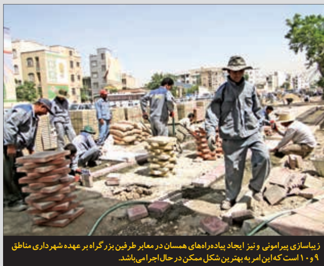
رمپ ورود به تراز منفی یک ادامه بزرگراه یادگار امام (ره) از شده و پس از پیچیدن یک مسیر حدوداً ۴۰۰ متری با شیب ۴
