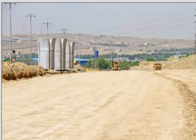
انعطاف پذیری در جانمایی پایه ها، سازه سبک، عدم نیاز به حمل و نقل بتن، آرماتور و قالب در سطح شهر و همچنین قابلیت اجرای طرح های متنوع، از دیگر شاخصه های فنی این پروژه است.
