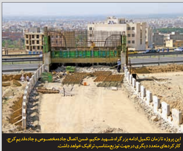
جانمایی مناسب محل حفاری‌ها و احداث شمع ستون‌ها، تأسیس قرار داده است.
