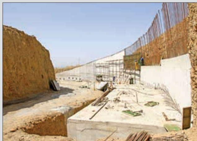
علاوه بر عملیات پل سازی، اجرای عملیات خاکبرداری، خاکریزی و نصب قطعات خاک مسلح به منظور احداث رمپ و لوپ های مورد نیاز، از مهم ترین جبهه های کاری این پروژه است.
