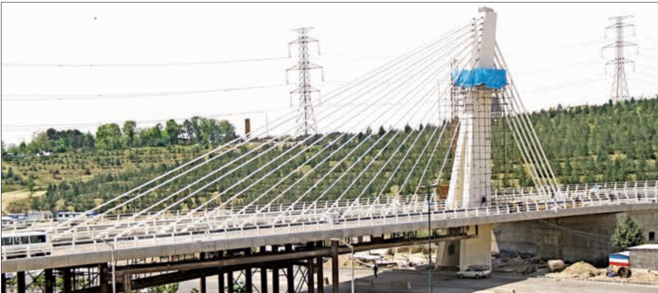
این روزها پل دسترسی غربی برج میلاد به عنوان سومین پل کابلی شهر تهران آماده بهره برداری شده است. این پل در غرب برج میلاد و روی بزرگراه شیخ فضل... نوری واقع شده و دسترسی به مجموعه برج میلاد را از هر دو باند شمال و جنوب بزرگراه شهید همت تأمین می کند
