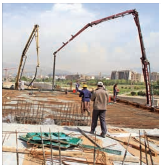
▼ متعاقب رفع معارض لوله آب ۸۰۰ میلی متر در باند شمالی پل وفادار، فونداسیون پایه های باقی مانده در این پل تکمیل شده و عملیات آرماتور بندی و قالب بندی ستون ها با سرعت مناسبی در حال انجام است.
