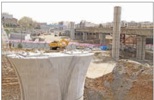
در سایر جبهه های کاری پروژه احداث تقاطع شهید گمنام با خیابان کارگر نیز عملیات خاکبرداری در بین پایه های ساخته شده و احداث دیوار حائل، عملیات خاکریزی در پشت کوله های پل اصلی نیز با پیشرفت مناسبی ادامه دارد.
