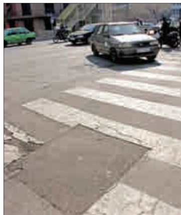
لکه‌گیری هندسی در تقاطع خیابان سپهد قرنیه با خیابان شاداب
