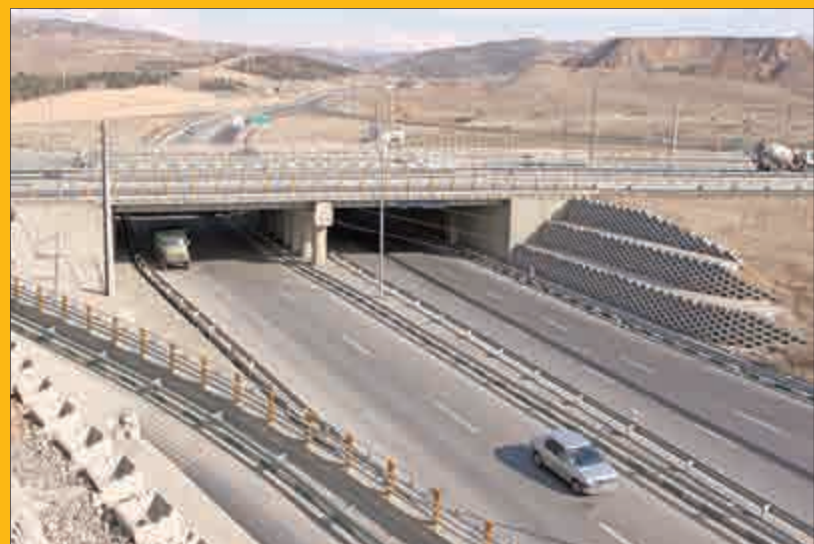
برطرف شدن گره ترافیکی بزرگراه شهید بابایی در محل تقاطع با جاده تلو، یکی از مهم ترین اهداف اجرای این پروژه بود. برای ایجاد کلیه ارتباطات مورد نیاز در محل این تقاطع لازم بود که ۱۵۰۰ متر از طول جاده تلو تعریض شود تا سطح سرویس دهی مناسب تری پیدا کند.
