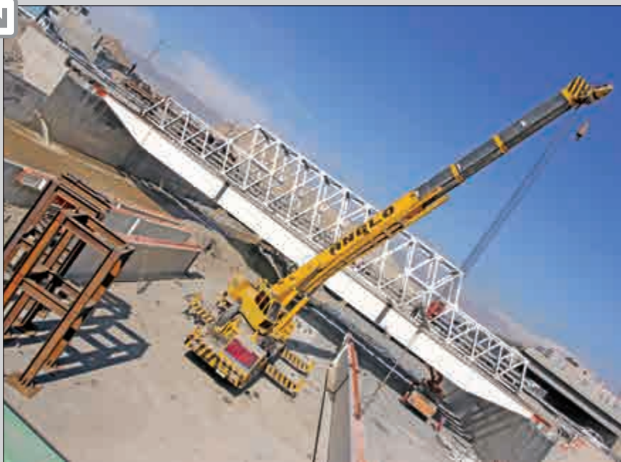
آغاز نصب قطعات پای فلزی اصلی در تقاطع بزرگراه فتح یا درواخته کن
