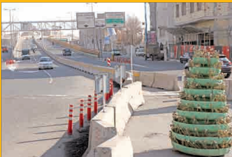
به اعتقاد بسیاری از شهروندان ساکن در پهنه شرقی پایتخت، میدان شهرک امید در ضلع غربی پل استقلال نیازمند اصلاح هندسی یا حداقل افزایش علائم هشدار دهنده ترافیکی است. اگرچه این میدان وظیفه تنظیم ترافیک محدوده ورودی شهرک امید را بر عهده دارد اما جانمایی نادرست آن حوادث زیادی در پی داشته است.
