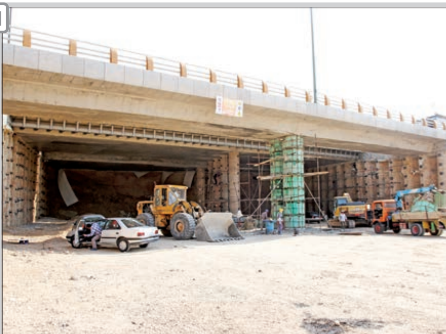
پیشرفت قابل ملاحظه عملیات احداث زیرگذر تقاطع بزرگراه‌های شهید چمران و شهید باقری
