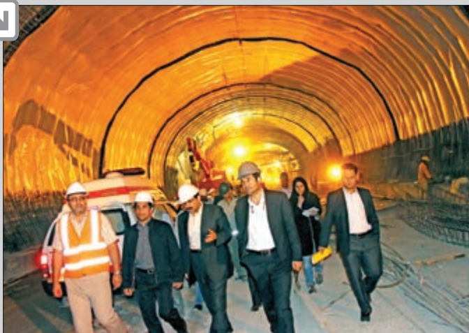
بازدید اعضای شورای اسلامی شهر تهران از پروژه تونل شهید حکیم
