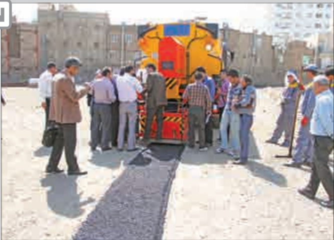
روشنایی از ماشین‌های سنگین که برای راه‌سازی در پروژه‌های عمرانی - دوشنبه ۱۲ خرداد ۱۳۹۳
