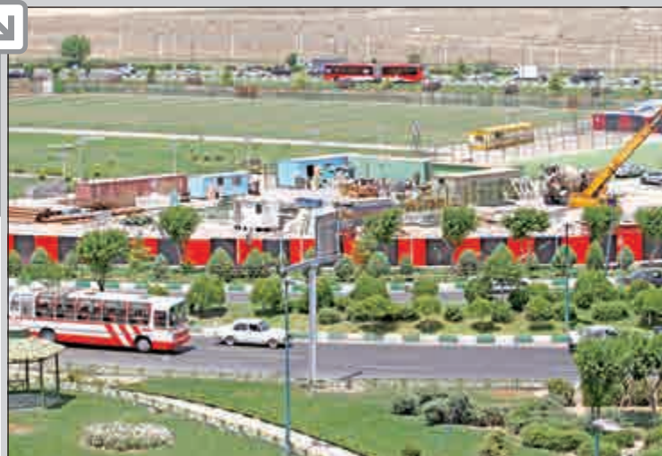
تجهیز کارگاه پروژه احداث بزرگراه یادگار امام (ره) - میدان فتح
