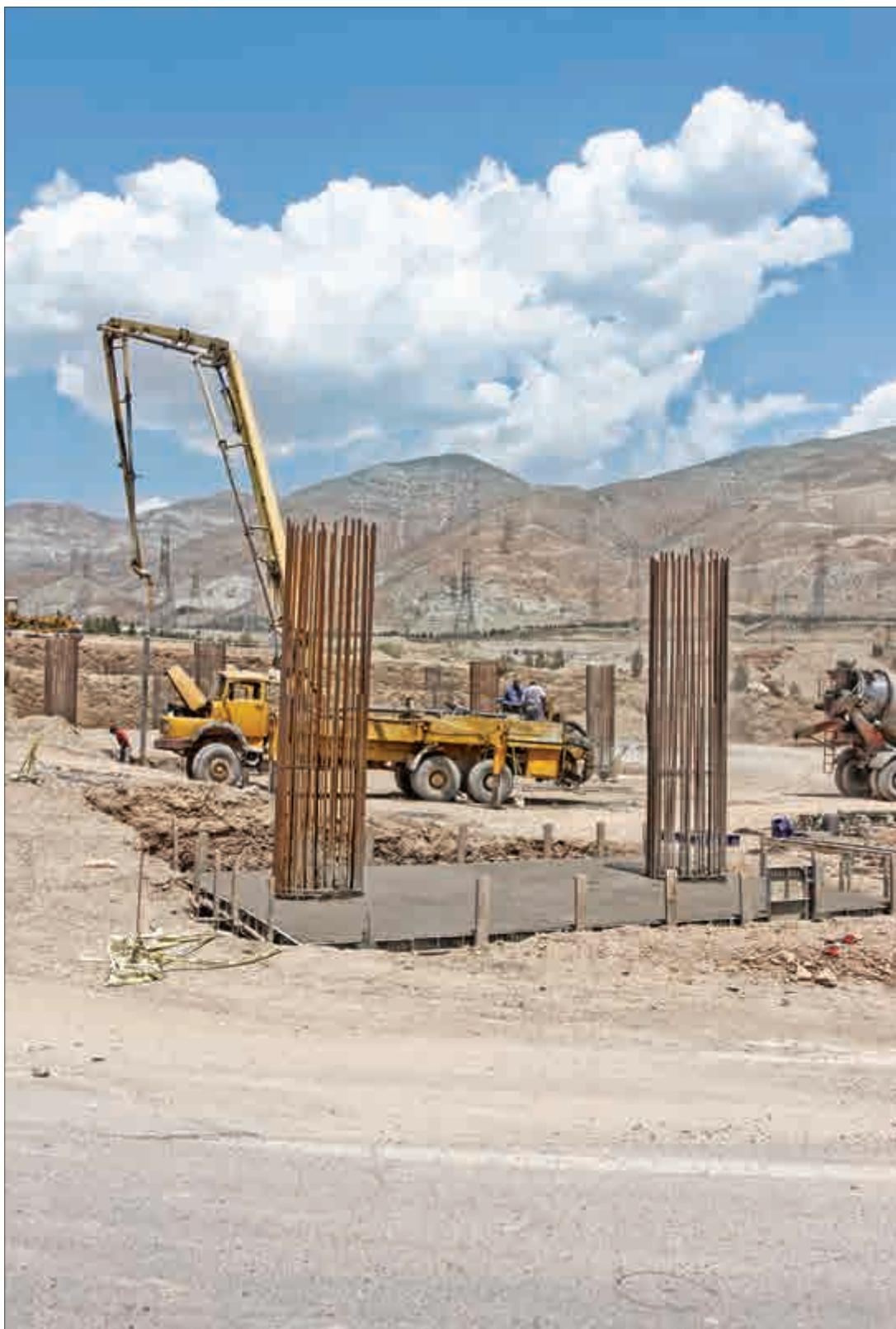
عملیات اجرایی احداث یکی از تقاطع‌های غیر همسطح در پروژه ادامه بزرگراه شهید حکیم
