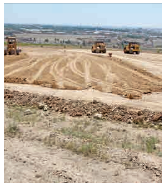
اجرای لایه‌های خاک‌ریزی در مسیرهای دسترسی تقاطع بزرگراه شهید حکیم با محور خادمین.
