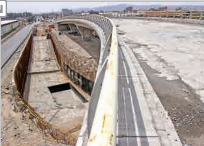
نمایی از پروژه تقاطع غیر همسطح خیابان امام حسین (ع) و شهر آریا با جاده قدیم قم
