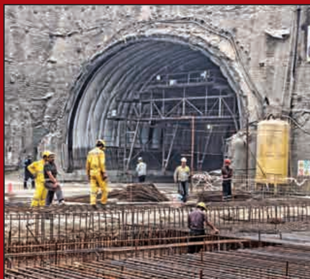
اجرای عملیات آرماتوربندی به عنوان یکی از اقدامات پیش نیاز اجرای بتن سازه ای کف، یکی از جبهه های فعال کاری پروژه است. در نتیجه این تلاش ها ۳۰ متر از کل بخش های پروژه زیر بتن سازه ای کف رفته است.
