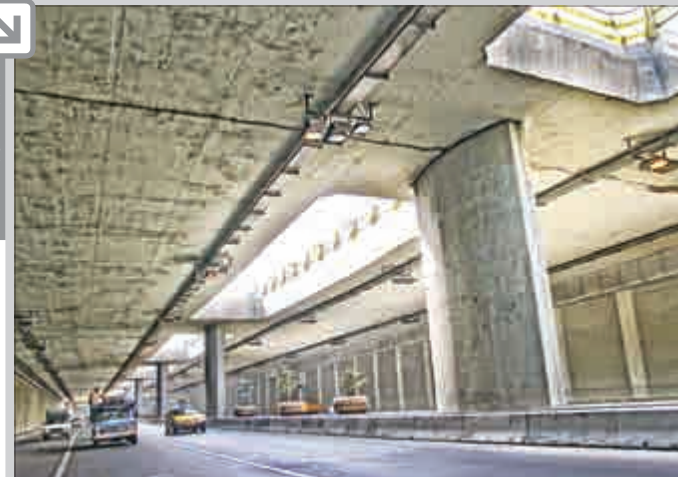
نمایی از وضعیت فعلی تردد در بخش طبقاتی بزرگراه پل یادگار امام (ره)
