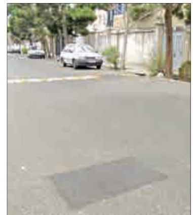
↑ خیابان حجر بن عدی، خیابان ۲۰۲. نمونه یک لکه گیری اصولی را می‌توان در این تصویر مشاهده کرد. سطح مناسب تراکم و استفاده از قیر در لایه‌های عمودی کار به خوبی مشخص است.
