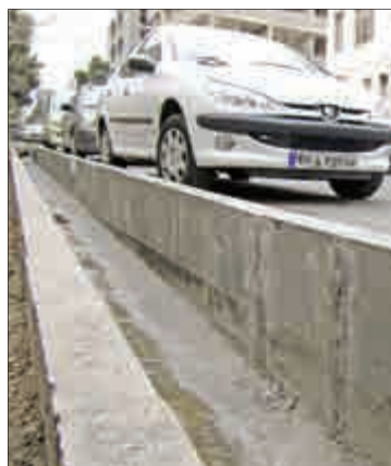
↑ خیابان سرنوشت شرقی، خیابان میرزا زاده، مقایسه ارتفاع جدول مرمت شده با در ب خود روی پارک شده نشان دهنده ارتفاع مناسب این عملیات است.
