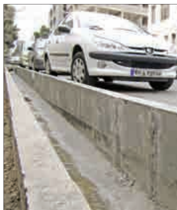
↑ خیابان سرنوشت شرقی، خیابان میرزا زاده، مقایسه ارتفاع جدول مرمت شده با در ب خود روی پارک شده نشان دهنده ارتفاع مناسب این عملیات است.
