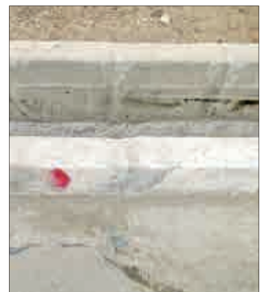
↑ خیابان سرنوشت شرقی، خیابان میرزا زاده، با وجود ارتفاع مناسب جدول، انتظار می‌رود عملیات کاتر زنی به طور صحیح پیش از اجرای تقویت بتنی صورت پذیرد.
