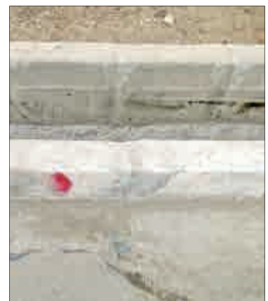
↑ خیابان سرنوشت شرقی، خیابان میرزا زاده، با وجود ارتفاع مناسب جدول، انتظار می‌رود عملیات کاترژنی به طور صحیح پیش از اجرای تقویت بتنی صورت پذیرد.
