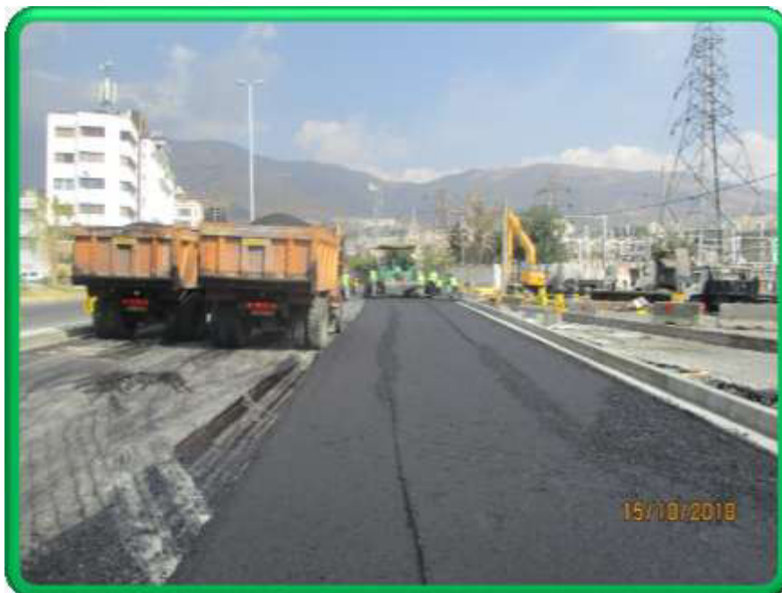
اجرای رویه آسفالتی محور اوشانی
