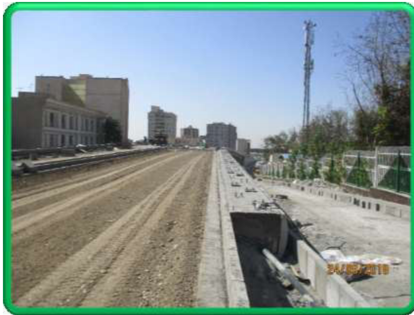
اجرای لایه زیر اساس در شیبراهه شمالی پل B6
