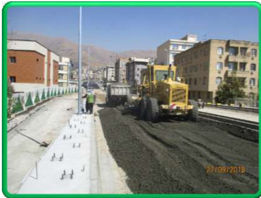
اجرای لایه RCC در شیب‌راهه شمالی پل B6
