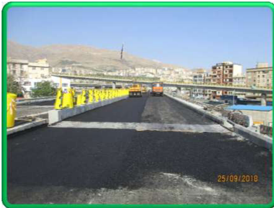
اجرای لایه آسفالت بر روی پل B13
