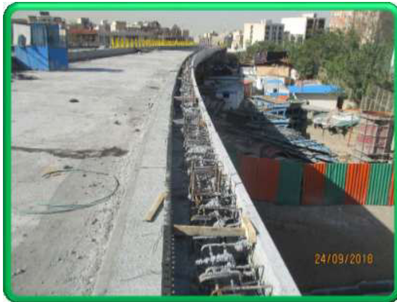
نصب قرنيز در پل B13
