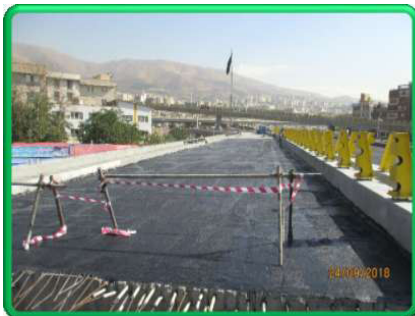
اجرای عایق و نصب پایه هندریل در پل B13
