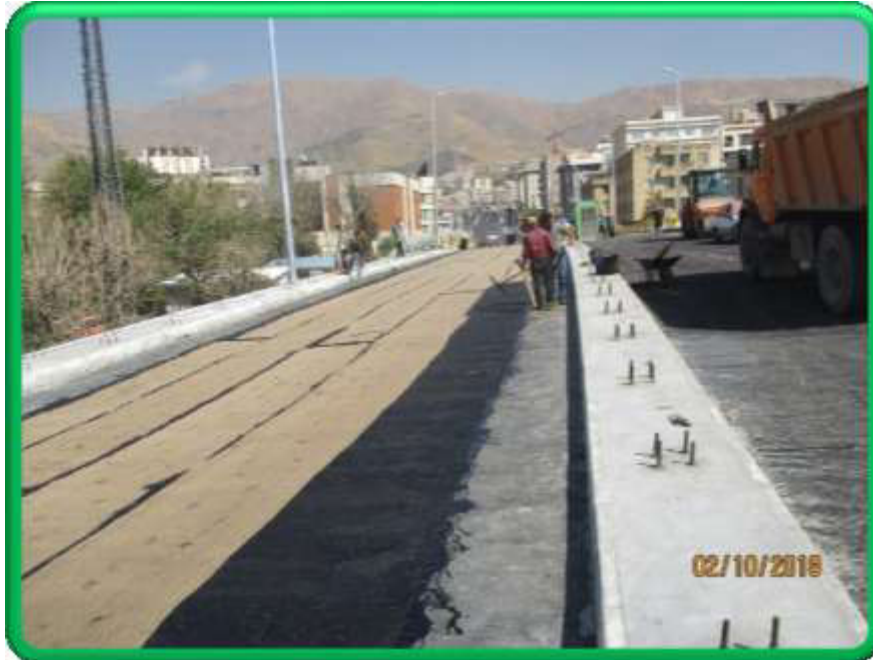
اجرای عایق بر روی پل B6
