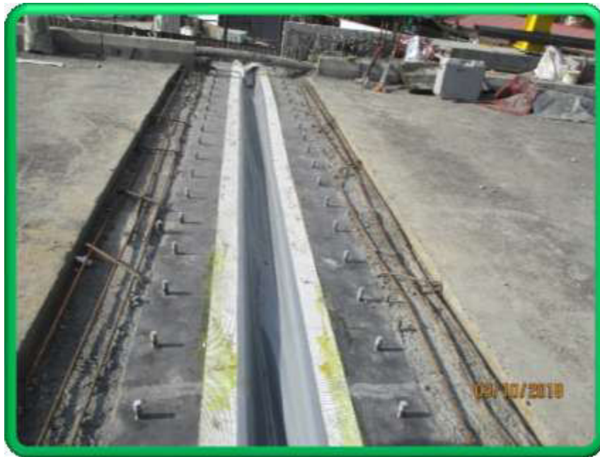
اجرای درز انبساط مابين پل B3 و B13
