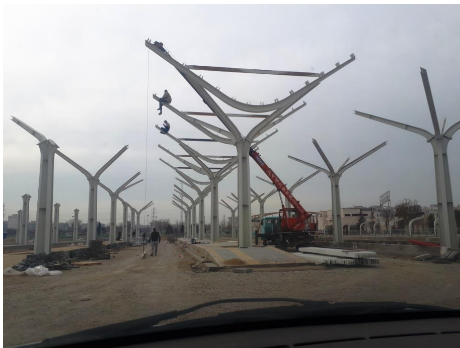
نصب پرلین محور هفتم سایبان اتوبوس ها
