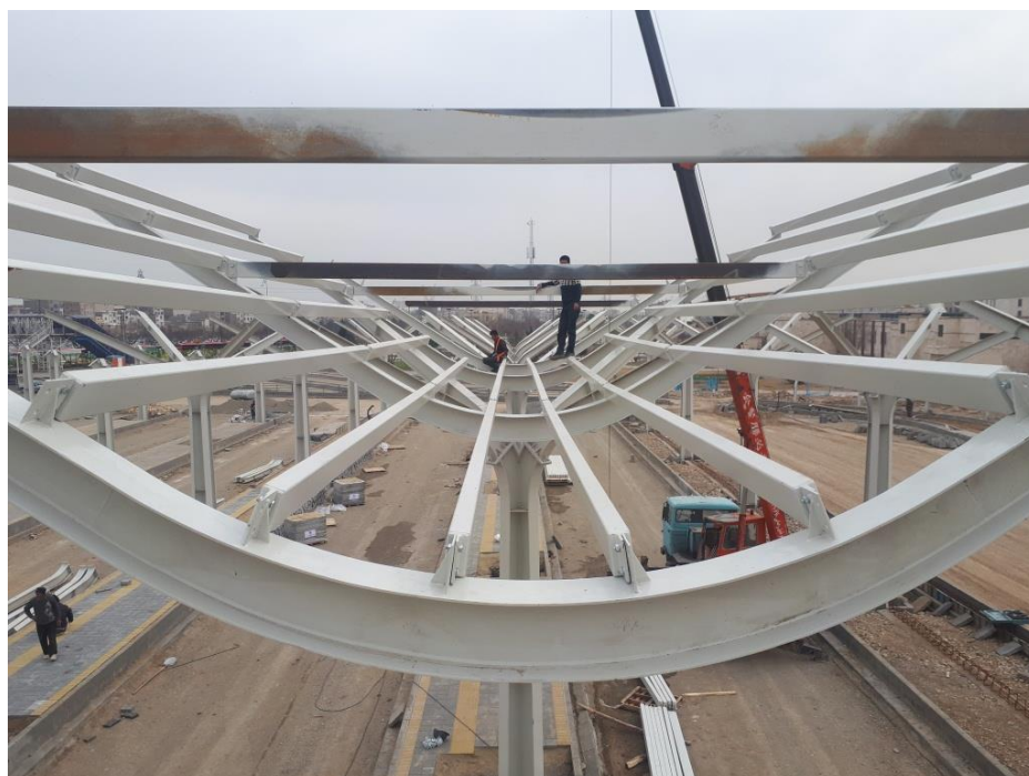
نصب پرلین محور هفتم سایبان اتوبوس ها
