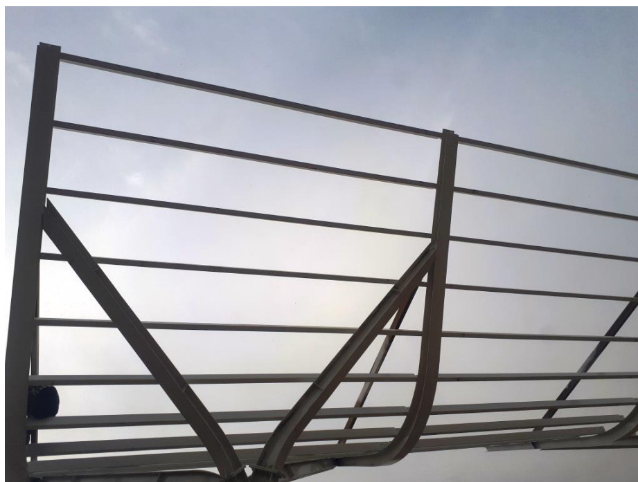
نصب پرلین محور هفتم سایبان اتوبوس ها
