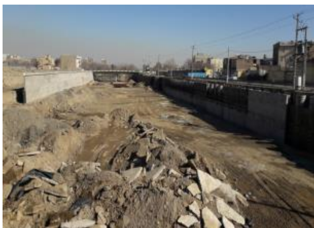
فاز 3- اجرای دیوار نمایی حد فاصل میرزایی تا اصغری
