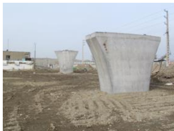
فاز 2- اجرای پایه های پل 45 متری کن
