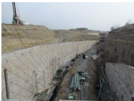
فاز 2- اجرای دیوارهای W6 محدوده 45 متری کن
