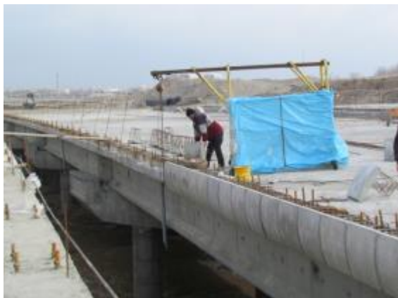
فاز 1- اجرای قرنیزهای پل رودخانه کن
