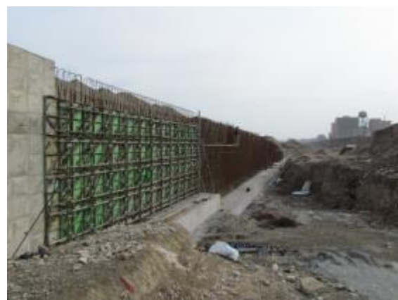
فاز 2- اجرای دیوارهای W1 محدوده 45 متری کن
