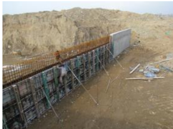
فاز 1- قالب بندی دیوار برگشتی پل رودخانه کن
