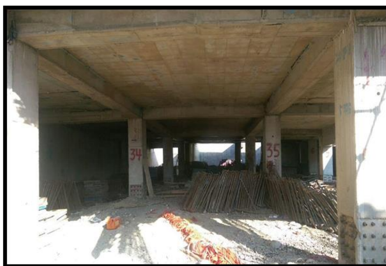
سقف بتن ریزی شده طبقه اول
