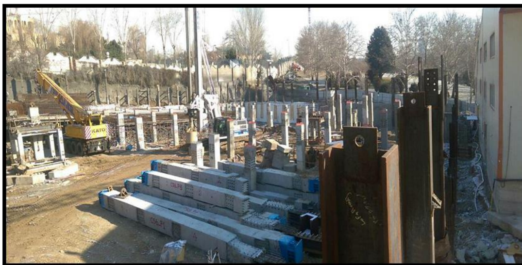
ستون های میانی نصب شده
